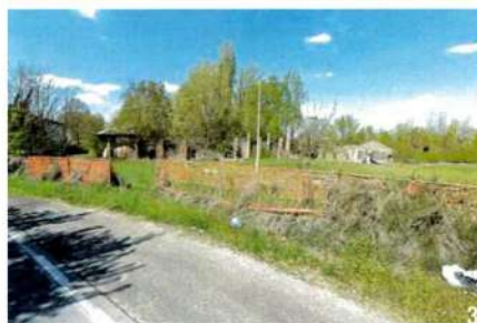
fotografie dello stato di fatto
